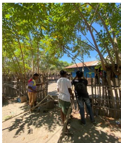
Gambar 3.4. pemasangan tiang lampu
