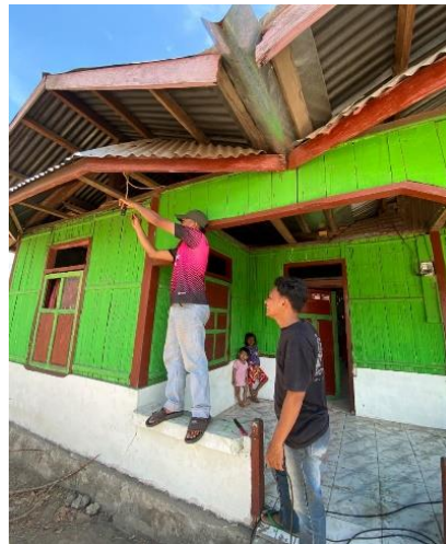
Gambar 3.3. Proses pemasangan Kabel Lampu
