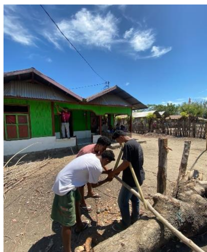
Gambar 3.1. pembuatan Tiang lampu
