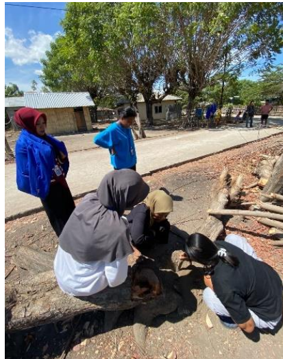
Gambar 3.2 Penggalian tempat berdiri lampu
